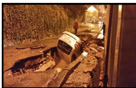
Via Isonzo, 100 metri a valle di via Pontetti – 4 novembre 2011
