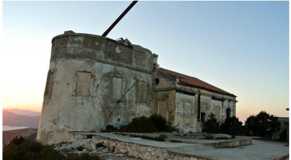
L'immobile è costituito da un fabbricato con torretta semicircolare. La pianta è longitudinale su un livello con torretta di avvistamento e segnalazione più elevata. La copertura del corpo longitudinale è a due falde con capriate lignee, mentre la copertura della torretta è a terrazza. L'interno è diviso da un corridoio che separa le due parti dell'edificio e termina con l'ambiente più ampio di forma semicircolare che costituiva l'ufficio di segnalazione.
